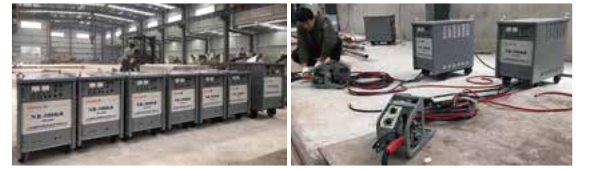
▲ 通用电焊机在中安联合煤化工项目安装调试现场
