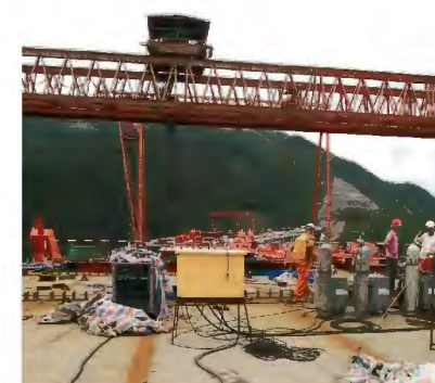
北盘江大桥 Beipanjiang Bridge
