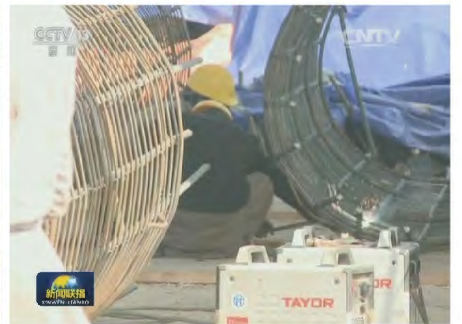
▲ 图为通用电焊机在“中巴公路”钢结构焊接施工现场 (图片截图转载CCTV中央电视台新闻联播)
