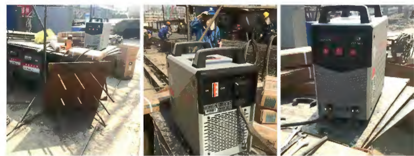
▲通用电焊机在杭州地铁2号线轨道焊接现场
